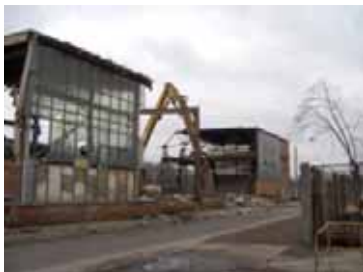
Alte Industriebauten mussten im GI-Süd weichen
