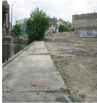
Fischereigelände nach dem Rückbau
