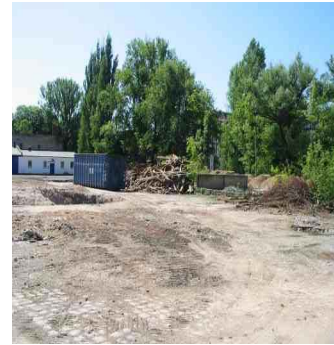
Rückbau ehem. Busbahnhof (Nr. 3)
