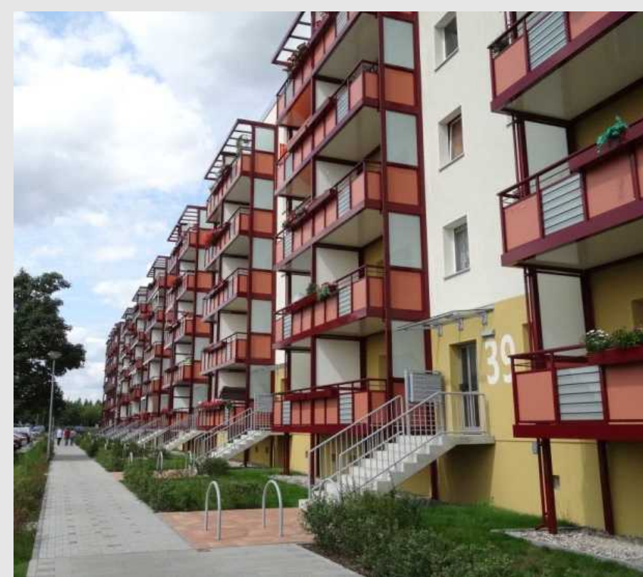
Sanierter Wohnblöcke Brahmstraße / Sophienstraße (Quelle: Stadt Brandenburg an der Havel)
