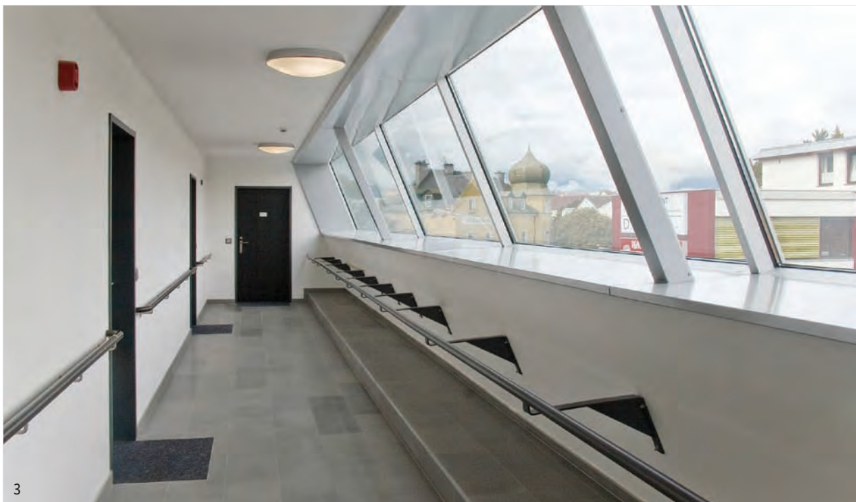
3 Markierung Eingänge, Handlauf als Orientierungshilfe – Tiroler Blinden und Sehbehinderten-Zentrum (Architekt DI Mayerhofer, architektur-ps, Foto Magdalena Possert)
