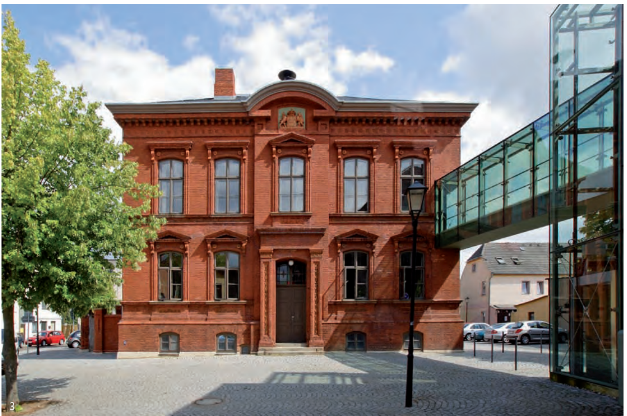
3 Anbau Aufzug – Ehemaliges Amtsgericht, Rathaus Malchow (Autzen & Reimers, Foto LAKD M-V Landesdenkmalpflege, A. Bötefür)
