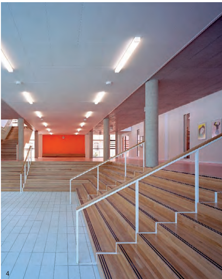
4 Mittlerer Handlauf und Stufenmarkierungen sowie Gestaltung durch verschiedene Bodenbeläge – 101. Mittelschule Dresden (Klinkenbusch + Kunze, Foto Volker Kreidler)
