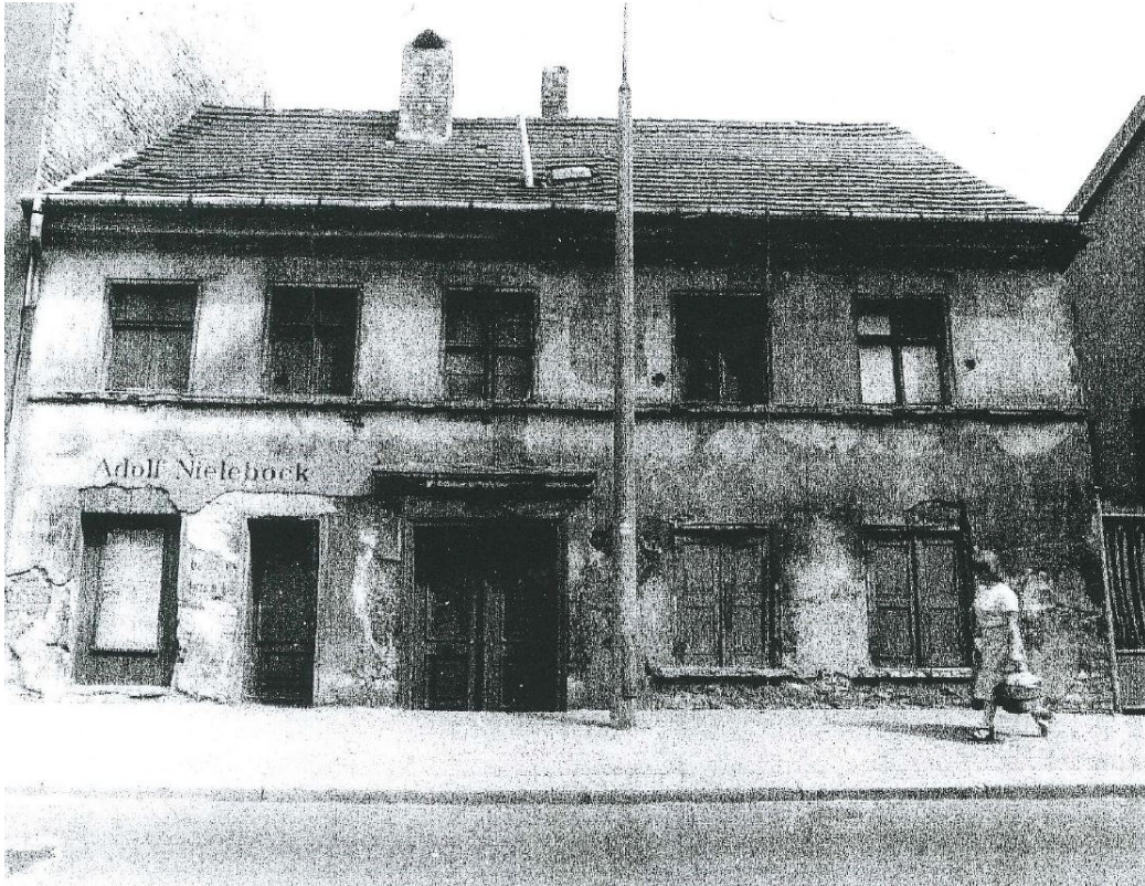
Früheres Wohnhaus Mühlendamm 6 vor dem Abriß
